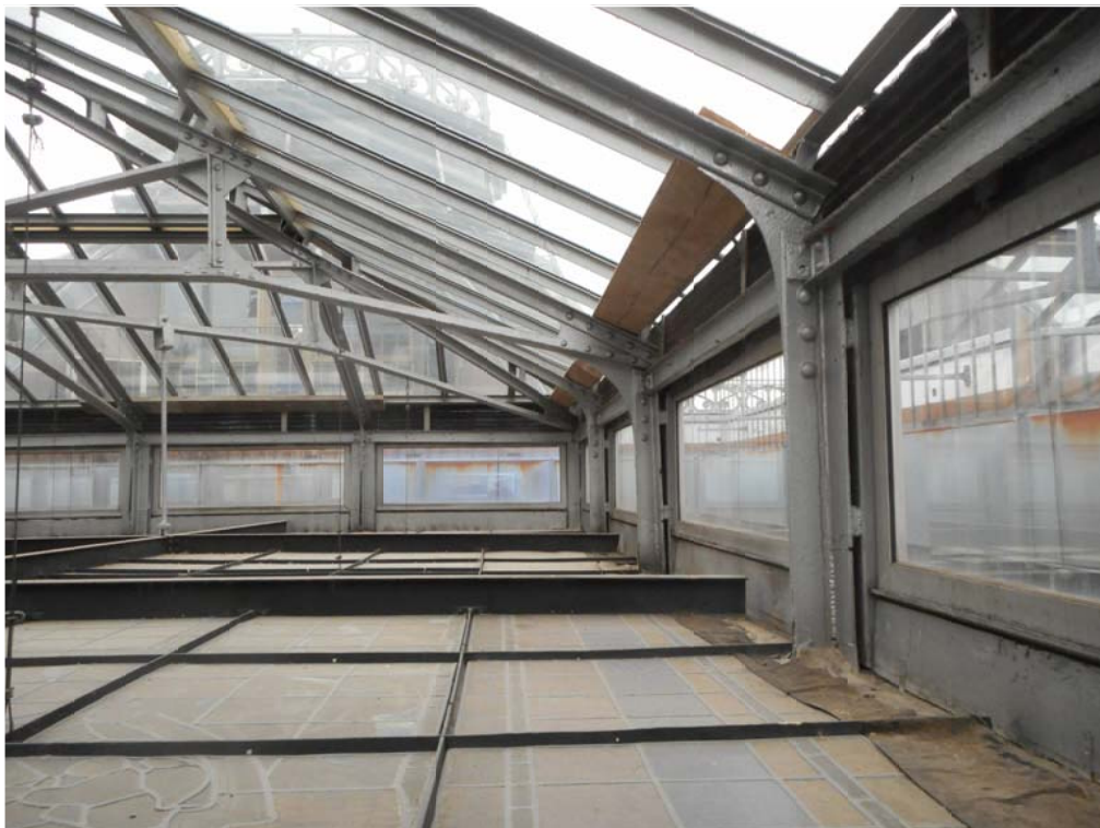
CUADRANTES 1, 4 Y 7 (CUADRANTE 7 en primer plano) Deformaciones en placas
