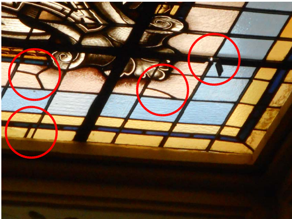
CUADRANTE 1, PIEZAS 1A+1B. Varias teselas partidas y fragmento de nervio de acero roto y a punto de caer
