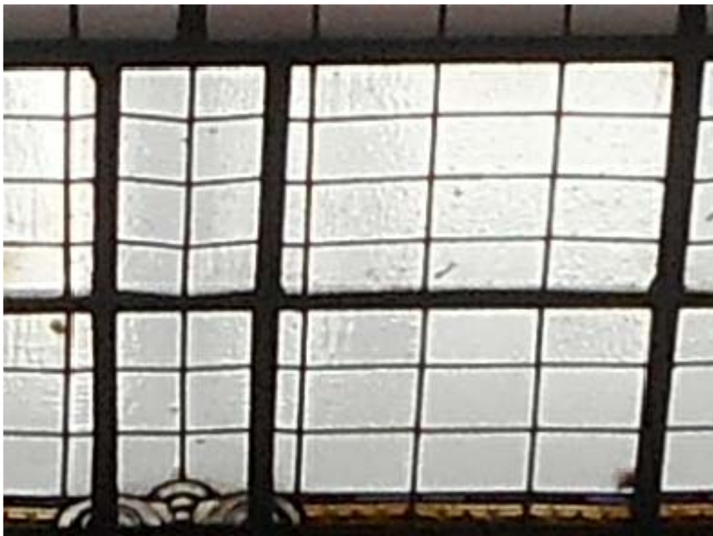
CUADRANTE 5. Falta de alineación en retícula y deformaciones en placas
