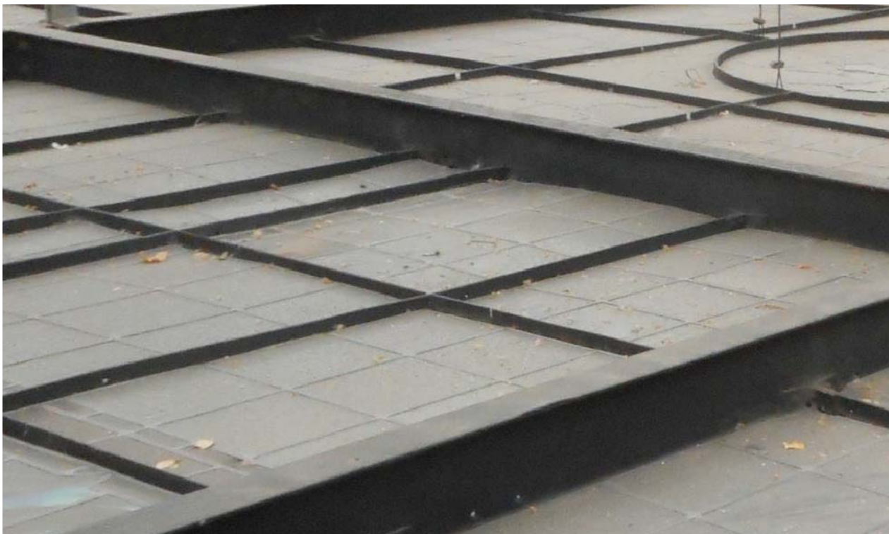
CUADRANTE 8, Cara superior. Deformaciones en placas.
